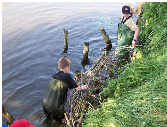
Einbau einer Faschine an einer Abbruchkante
